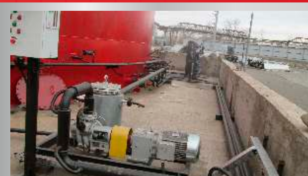
Установка насосная битумная на базе насоса VICTOR PUMPS и мотор-редуктора FAM, Италия
